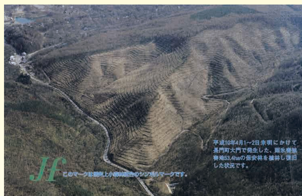
雨氷害被害地 53.4ha の保安林を植林し復旧した様子 (長和町大門)
