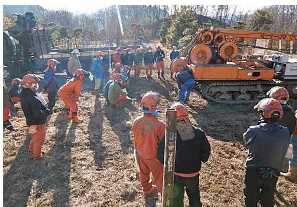
1日目 タワーヤード点検の様子
